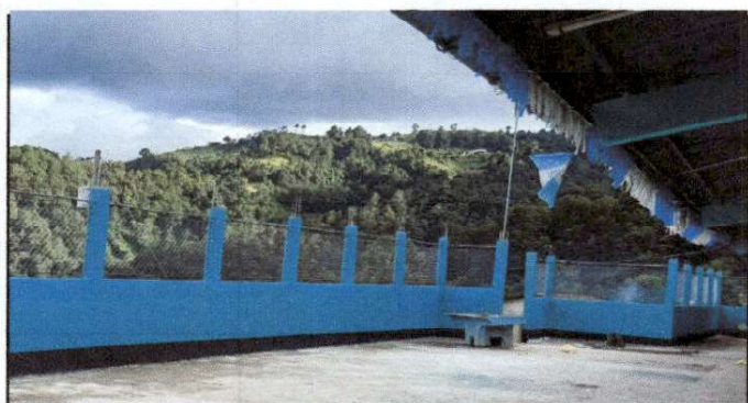
Foto 5: reparación de muro perimetral de blokc con tubo HG y malla galvanizada, soleras intermedias y columnas.
