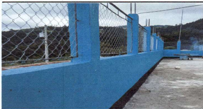
Foto 1: Reparación de muro perimetral de blokc con tubo HG y malla galvanizada, soleras intermedias y columnas.
