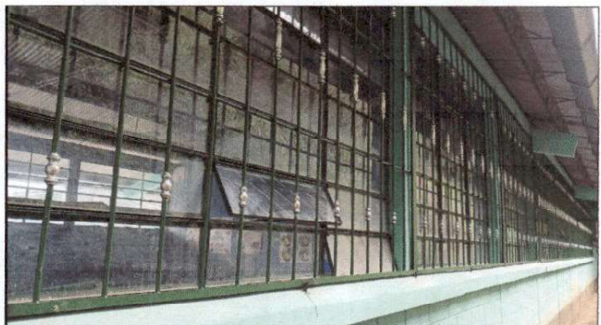
Foto 4: Instalación de balcones de hierro en ventanas
