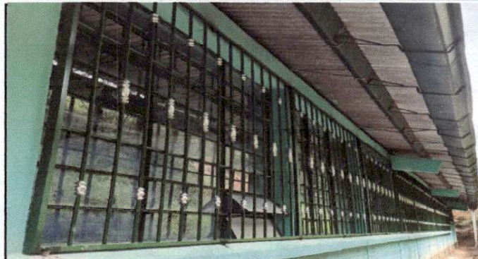
Foto 2: Instalación de balcones de hierro en ventanas
