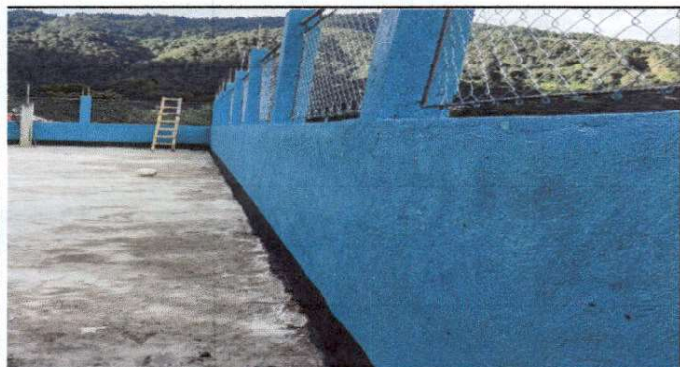
Foto 3: reparación de muro perimetral de blokc con tubo HG y malla galvanizada, soleras intermedias y columnas.
